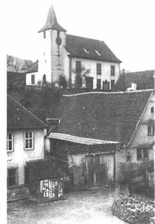
Auf der Anhöhe die Kirche. Davor alter Bauzustand: links Rathaus mit Waghäule, rechts Hofreite Hellenschmid/Raub mit fränkischem Hoftor
