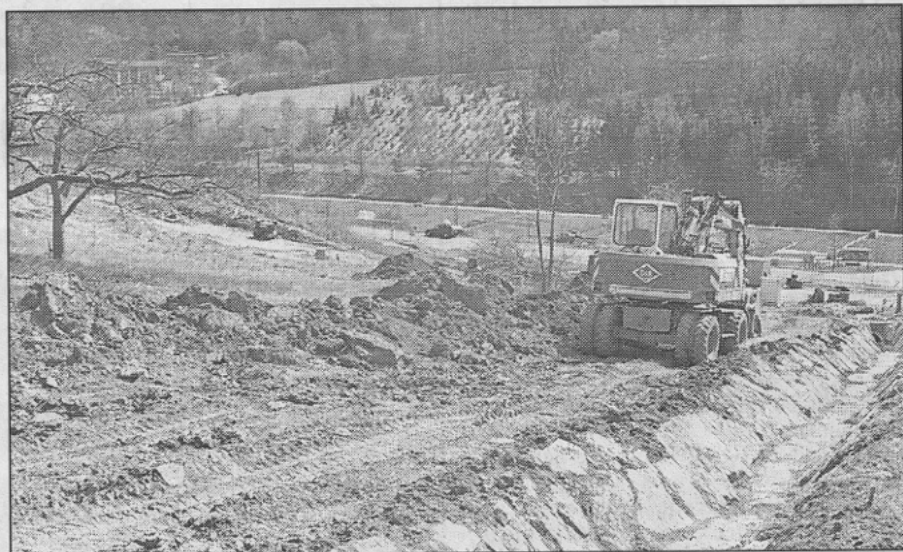
ZÜGIG VORAN gehen die Erdarbeiten beim Kembacher Neubaugebiet »Buschhölzlein«, mit dem sich der Ortschaftsrat befaßt. Foto: Hörner
